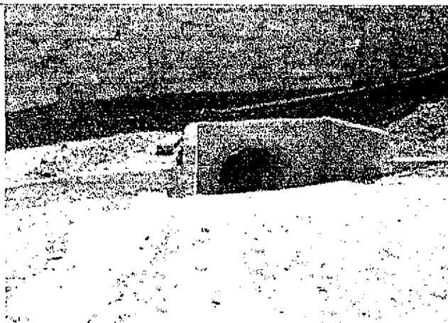
FOTO 05 - Boca de Lobo recém-construída no final da Rua U, próxima da entrada da Chácara da família Passos.
