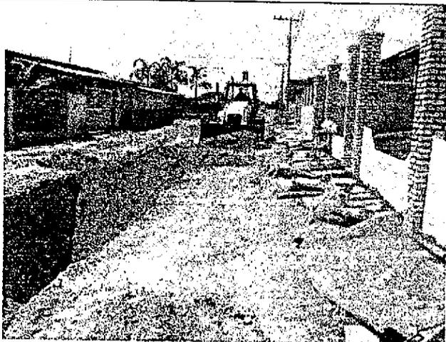
FOTO 07 – Vista da máquina pesada aterrando rede tubular de drenagem pluvial já colocada.
