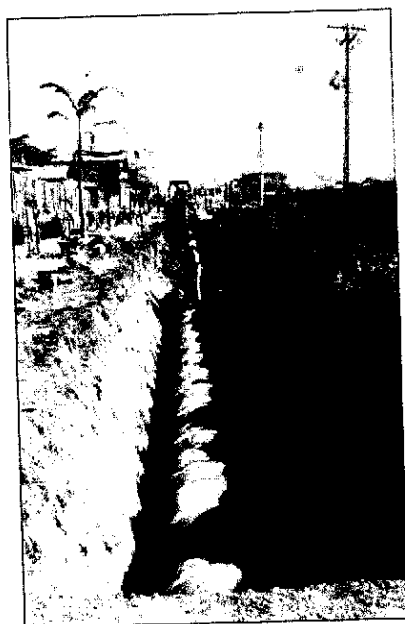
Águas pluviais Origem da foto: www.residencialrk.com.br
