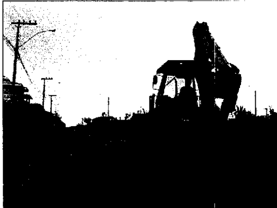
Foto 1 – Máquina trabalhando, espalhando britas nas vias.
