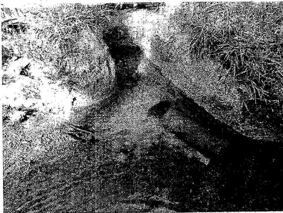
**Figura 11 - Danos ao sistema de drenagem já implantado**
