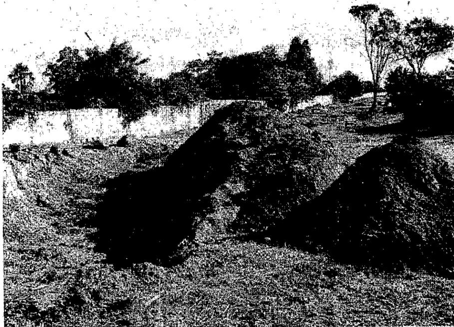
**Figura 8 - Obras de contenção (bacia de retenção) de águas pluviais realizadas pelo condomínio com objetivo de minimizar os efeitos causados pelas águas pluviais**
