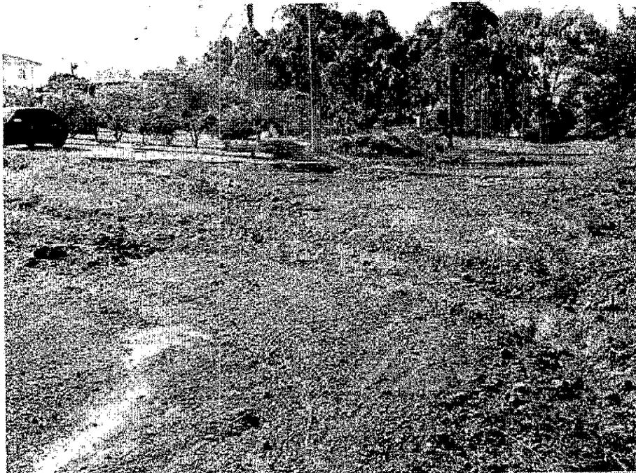
**Figura 10 - Processo de erosão iniciado em rua não pavimentada**
