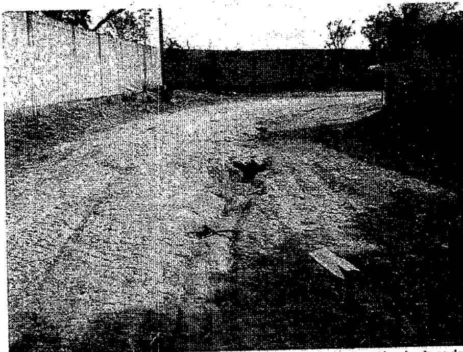
Figura 5 - Erosão em processo inicial no topo do trecho com inclinação maior da via perimetral
