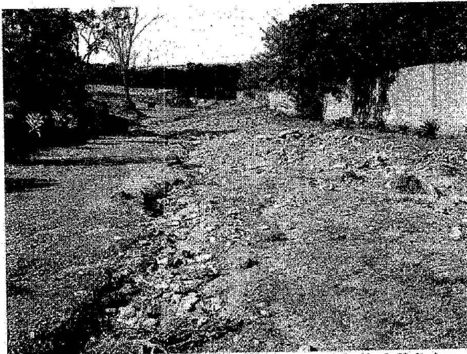
Figura 6 - Erosão em estágio avançado na porção mais baixa da via já citada
