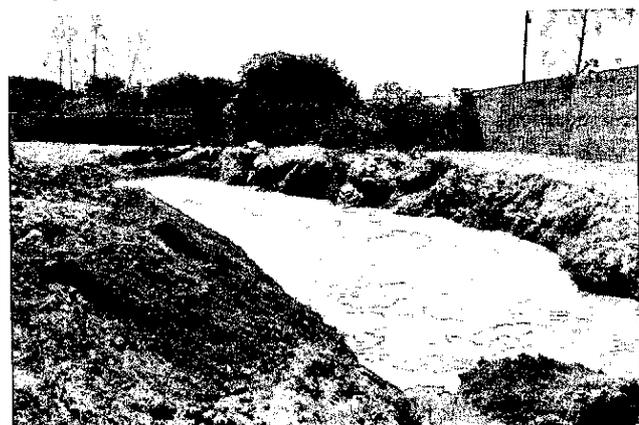
Fotografia 6: Outra vista da estrutura física, barreira de contenção, que acaba por reter alguma acumulação de águas escoadas.
