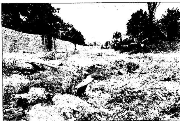
Fotografia 2: Detalhe dos processos erosivos ocorrentes numa via não pavimentada do condomínio RK.
