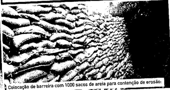
Colocação de barreira com 1000 sacos de areia para contenção de erosão:
