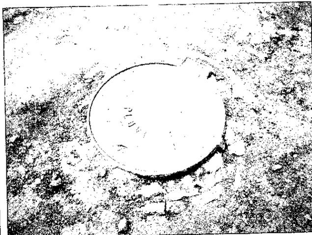
**Foto 13** – Poço de visita do trecho já instalado da rede de drenagem pluvial .
