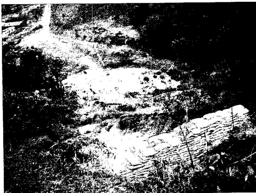
**Foto 8** – Vista da erosão aos fundos do parcelamento, com solução paliativa utilizando sacos de areia para amortecimento das águas.
