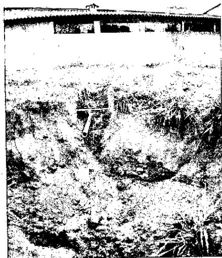
**Foto 19** – Solução improvisada para destinação de águas servidas de residência no parcelamento "Condomínio RK".
