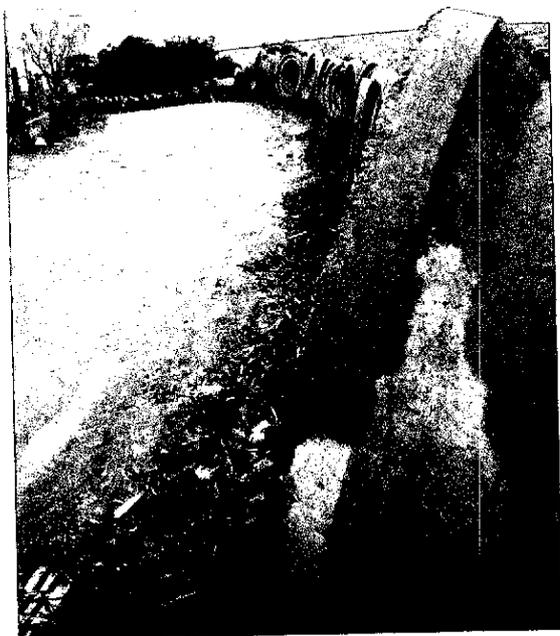
**Foto 5** – Manilhas de concreto aguardando a continuidade de instalação da rede de drenagem pluvial.
