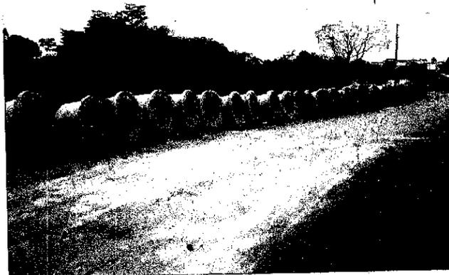
**Foto 6** – Manilhas de concreto aguardando a continuidade de instalação da rede de drenagem pluvial
