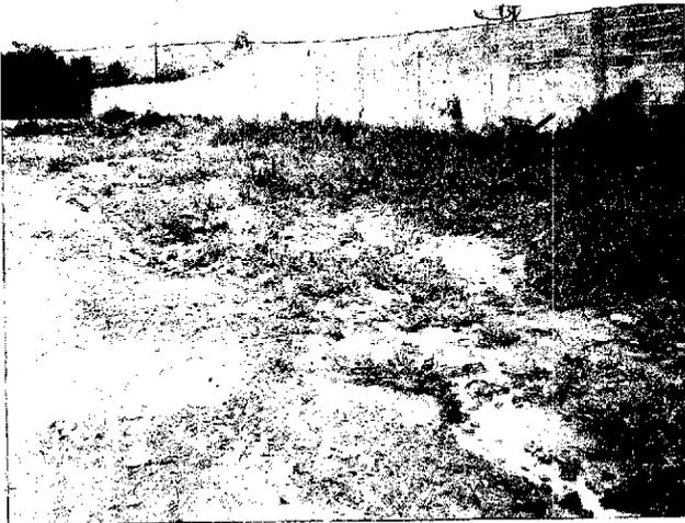
**Foto 18** – Situação padrão das ruas do parcelamento: escoamento superficial de águas pluviais com início de processo erosivo.
