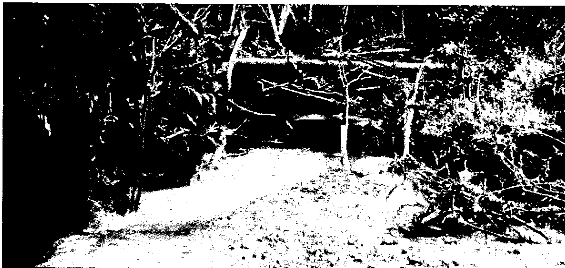
Figura 7.2.D – Vista panorâmica do intenso desmatamento de mata galeria nas margens do ribeirão Santa Maria.
