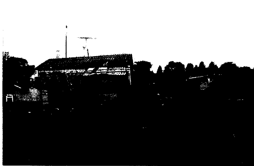
Figura 6.9.1.2.1.N- Trecho 6J - 7J (Casa do caseiro).
