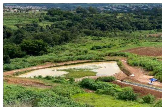
Bacia de contenção das águas da escada hidráulica
