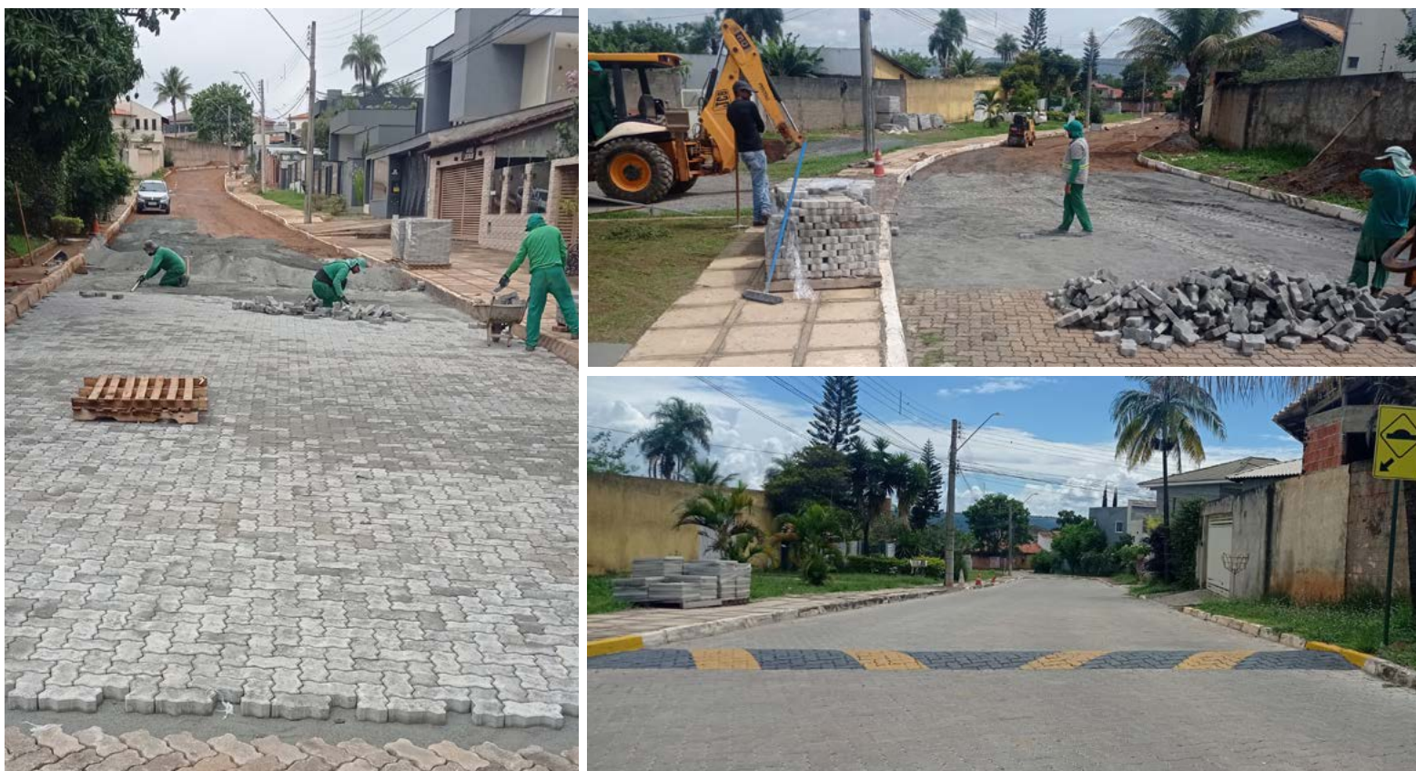
Rua dos Buritis - Recuperação do subleito, compactação e instalação de bloquetes novos, instalação de meios-fios, sarjetas, quebra-molas e bocas de lobo
