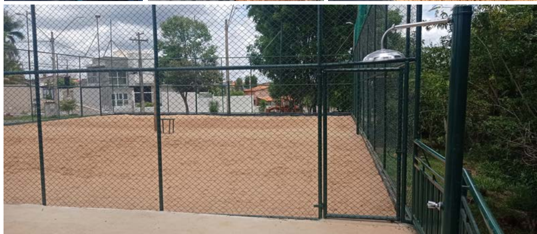
A QUADRA DE AREIA foi ampliada e recebeu areia nova, além da reforma do alambrado e tela de proteção nas laterais. Foram instaladas uma nova ducha e uma nova calçada. Com a ampliação é possível dividir a quadra e usá-la como duas
