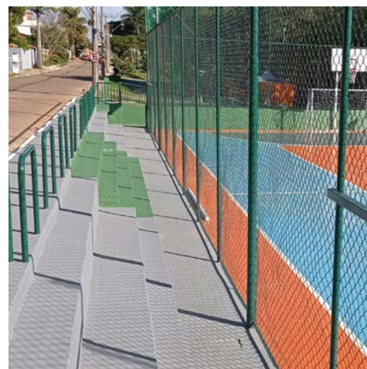
A QUADRA POLIESPORTIVA ganhou pintura nova no piso com uma marcação mais visível para as diversas modalidades. O alambrado ganhou pintura nova e rede de cobertura, as calçadas e arquibancadas foram melhoradas com o acréscimo de mais degraus e diversas melhorias no entorno da quadra foram executadas
