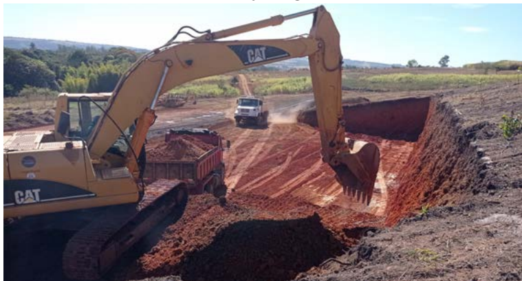
Início da escavação da bacia do Antares
