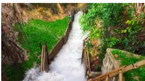
Com proteção de encostas por meio de paliçadas, rip-rap, aterros e recomposição vegetal a escada hidráulica está em pleno funcionamento há mais de dois anos
