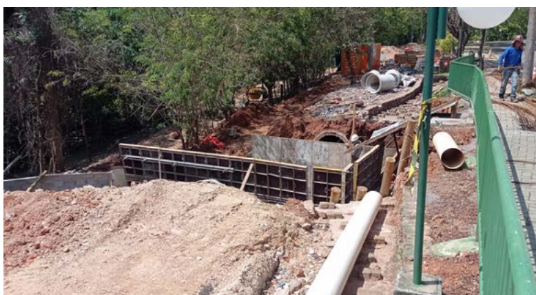
Construção da caixa dissipadora da rua do Mirante, no início da escada hidráulica. Solução criativa que permitiu corrigir a erosão e reduzir a dimensão da rede do Antares
