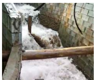
Com proteção de encostas por meio de paliçadas, rip-rap, aterros e recomposição vegetal a escada hidráulica está em pleno funcionamento há mais de dois anos
