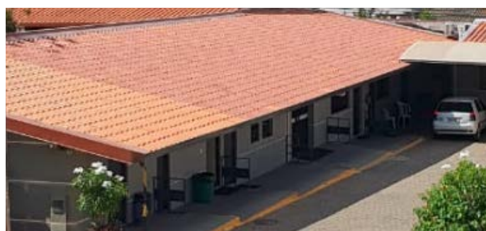
O telhado do anexo administrativo foi reformado com a colocação de manta e substituição de madeiras e telhas que estavam danificadas
