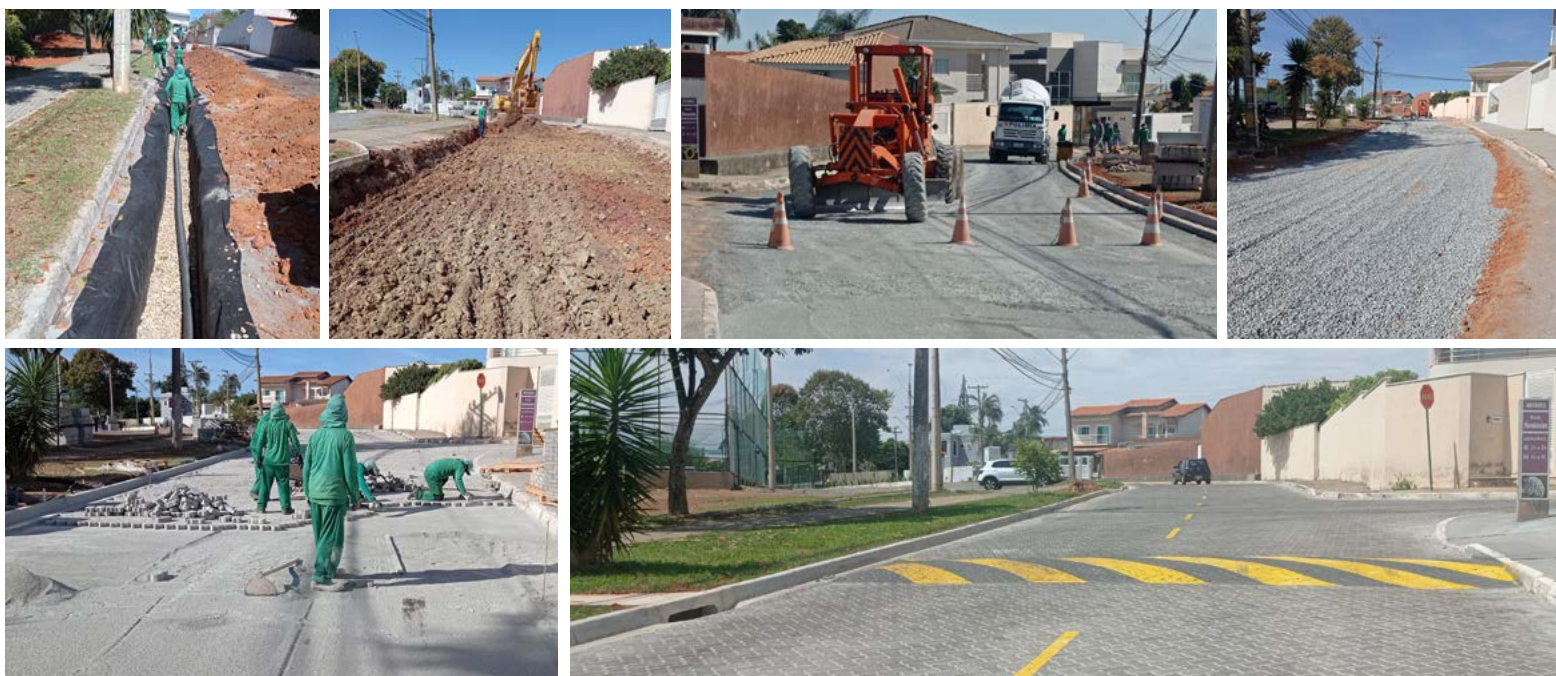
Rua do Mirante - Recuperação do subleito com aplicação de 700 toneladas de brita, compactação e instalação de bloquetes novos, instalação de meios-fios e sarjetas, novas bocas de lobo com lançamento em caixas de infiltração e recuperação da pista de caminhada e da área verde
