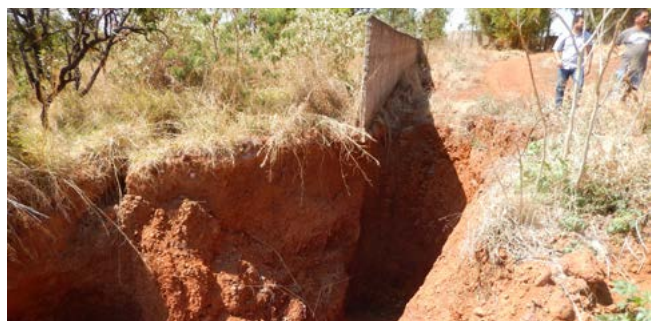
Alguns danos no RK e nas chácaras vizinhas causados pelas águas pluviais que corriam superficialmente
