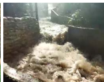
Com proteção de encostas por meio de paliçadas, rip-rap, aterros e recomposição vegetal a escada hidráulica está em pleno funcionamento há mais de dois anos
