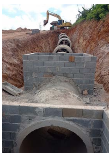
Galeria com degraus e caixas de visitação para manutenção
