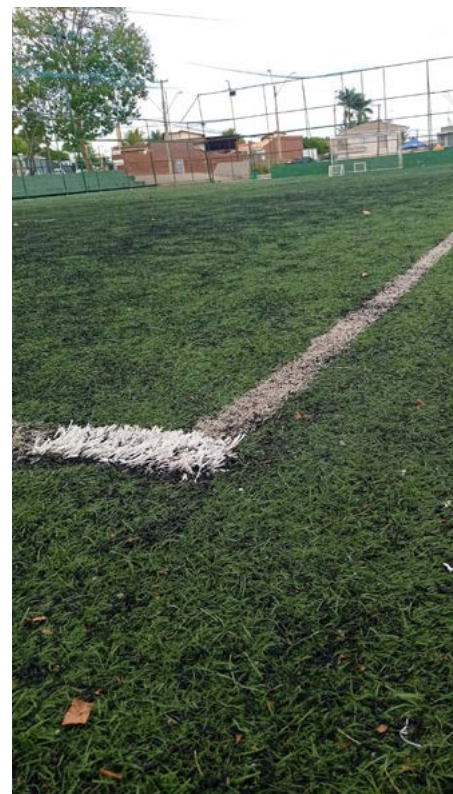
O CAMPO DE GRAMA SINTÉTICA foi reformado com correção das partes que estavam danificadas e recebeu nova cobertura de borracha
