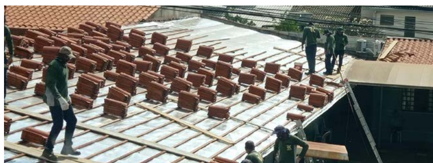
O telhado do anexo administrativo foi reformado com a colocação de manta e substituição de madeiras e telhas que estavam danificadas
