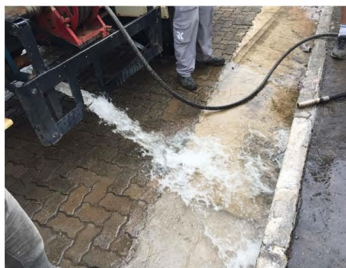
Figura 6 – Teste com caminhão pipa
