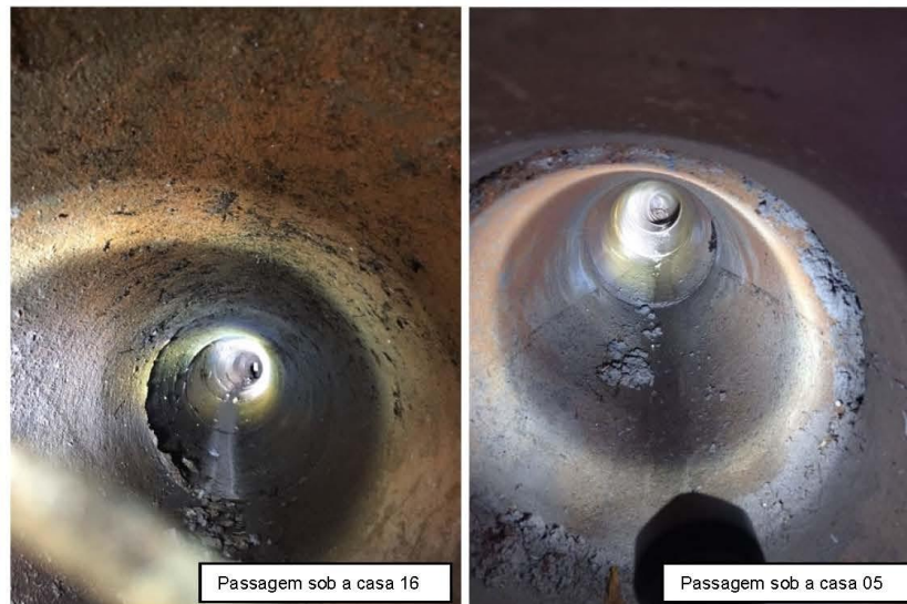
Figura 5 – Tubulação que passa sob as casas 16 e 05, interligando uma rua a outra DN 400mm
