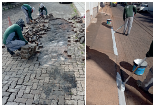
Manutenção permanente das ruas com substituição dos bloquetes danificados ou asfalto, além da pintura de meios fios
