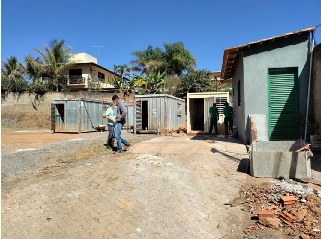
Figura 3 – Montagem do Canteiro de Obras
