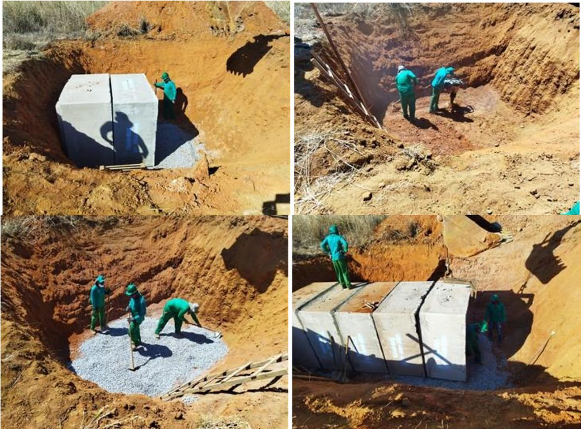
Figura 9 – Início das instalações das galerias
