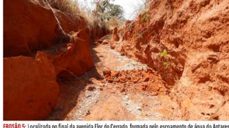
EROSÃO 5: Localizada no final da avenida Flor do Cerrado, formada pelo escoamento de água do Antares e Centauros. A voçoroca atingiu quase um quilômetro de comprimento
