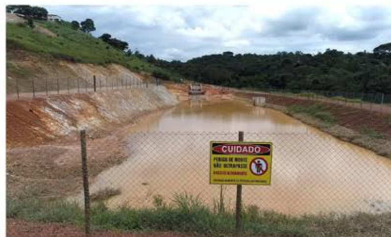
O sistema de drenagem do Antares conta com dois reservat3rios independentes
