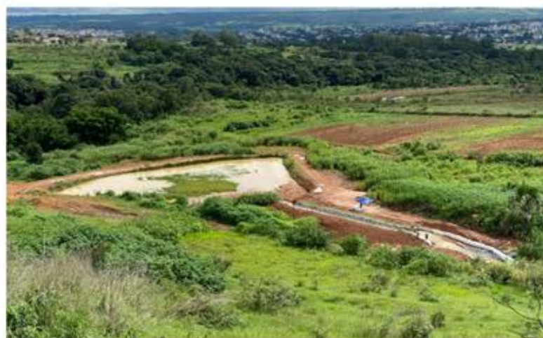
O sistema de drenagem do Antares conta com dois reservat3rios independentes
