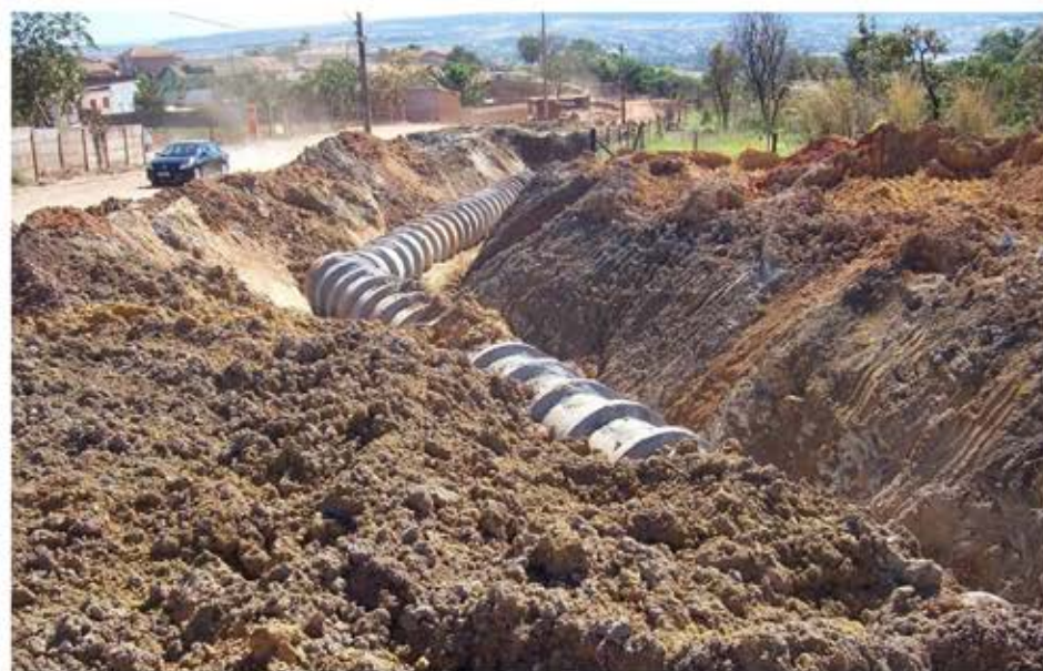
Construção da microdrenagem (rede interna). Rua do Mirante 2007
