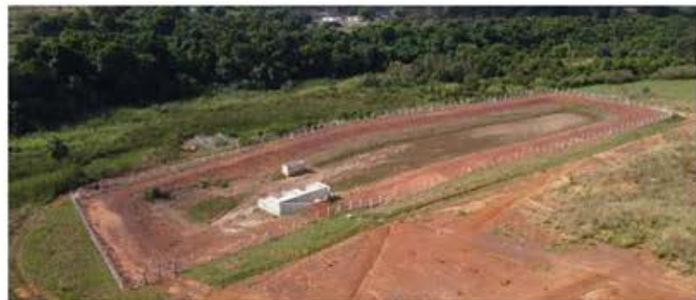
Reservatório do Centauros, dissipador duplo, caixa vertedora e dissipador de gabião
