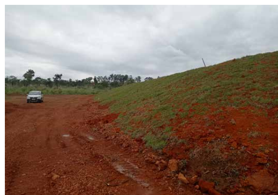
Plantio de grama para proteção do talude da bacia
