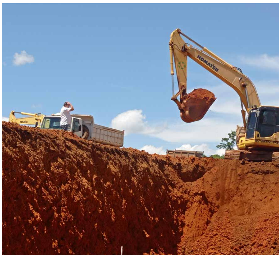
Escavação da bacia de contenção
