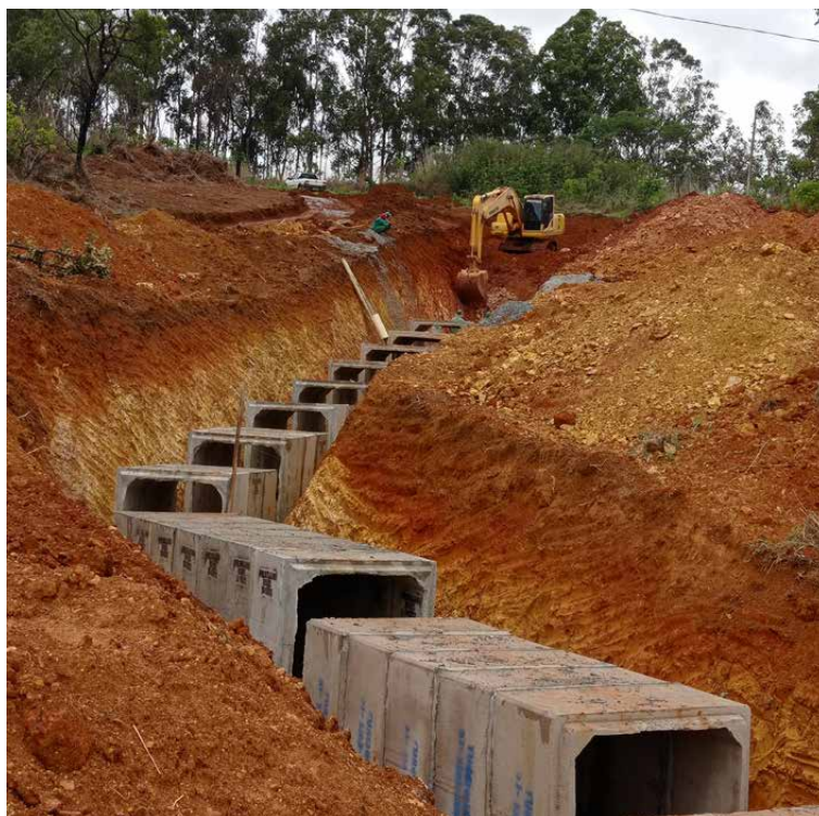
Galeria de 1,65 x 1,65m chegando ao muro do RK
