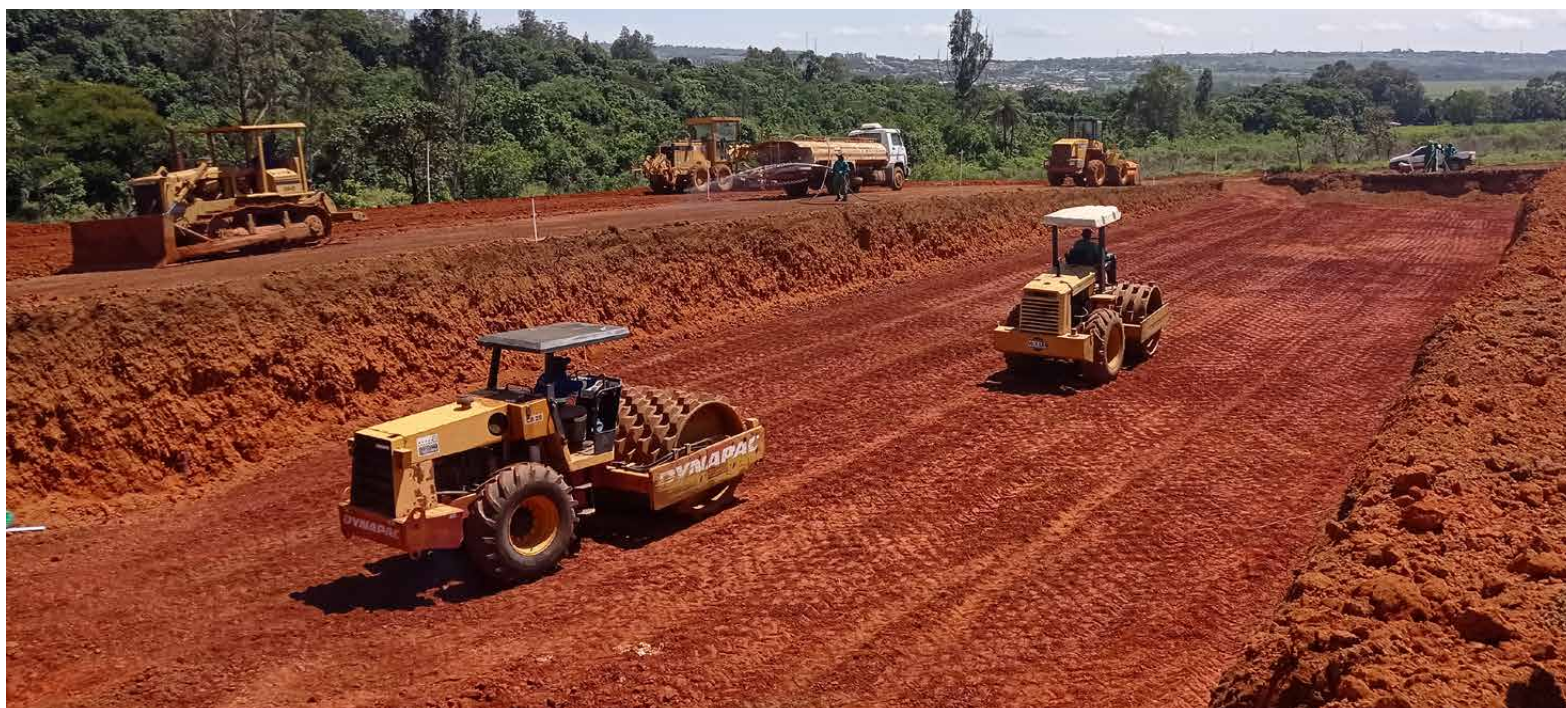
Construção da bacia de contenção
