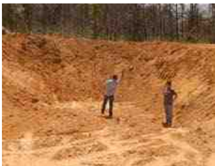
Foram construídos na área externa bolsões, curvas de nível e escadas de amortecimento para amenizar os danos ambientais
