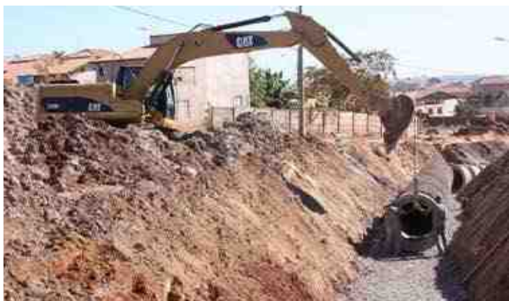
Construção da microdrenagem (rede interna) - Trecho na rua do Mirante ao lado do campo de futebol - 2007
