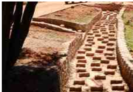
Construção de escadas, canaletas e bolsões na área interna do RK para amenizar os estragos causados pelas águas que correm superficialmente
