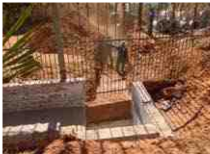
Construção de escadas, canaletas e bolsões na área interna do RK para amenizar os estragos causados pelas águas que correm superficialmente
