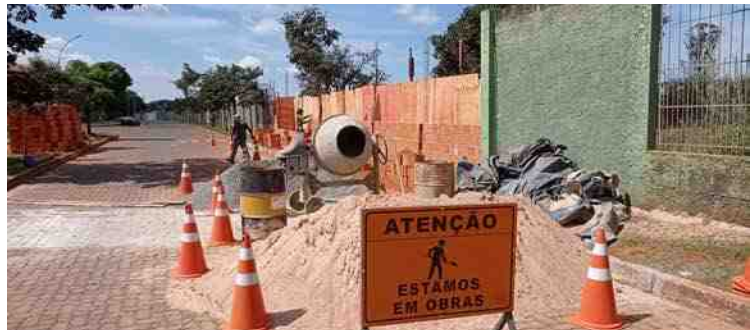
Reconstrução de trecho de muro danificado
