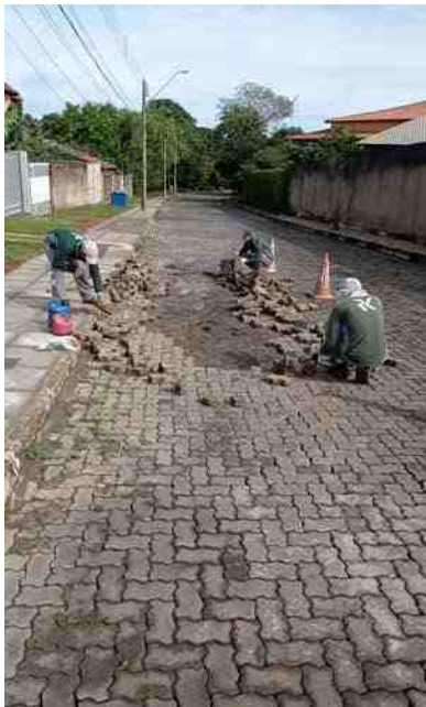
Recuperação de trechos danificados das ruas do RK em decorrência das águas de chuva que ainda correm superficialmente
