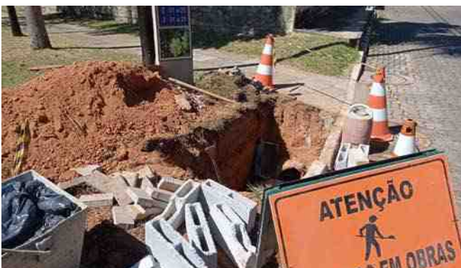
Recuperação de trechos danificados na rede interna de águas pluviais e abertura das bocas de lobo
