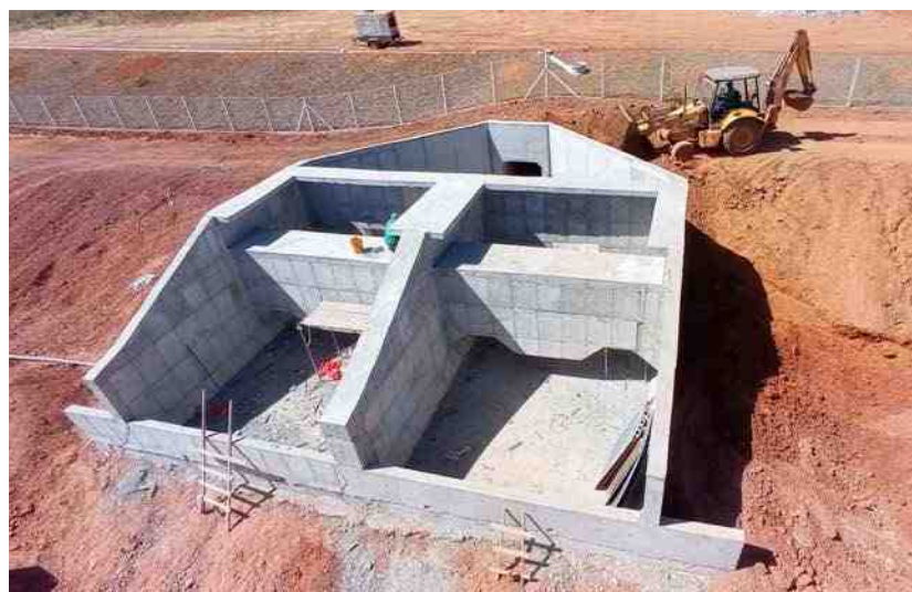
Finalização da construção do dissipador na bacia rede Centauros
