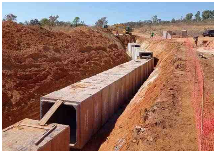
Início da escavação e colocação das galerias de 1,65x1,65m
