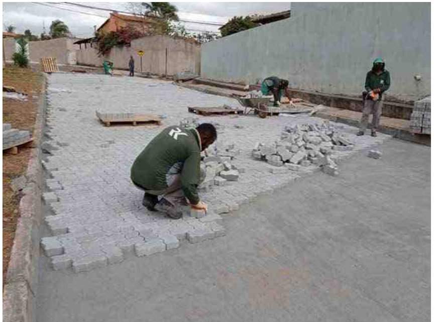
Recuperação de trechos danificados das ruas do RK em decorrência das águas de chuva que ainda correm superficialmente
