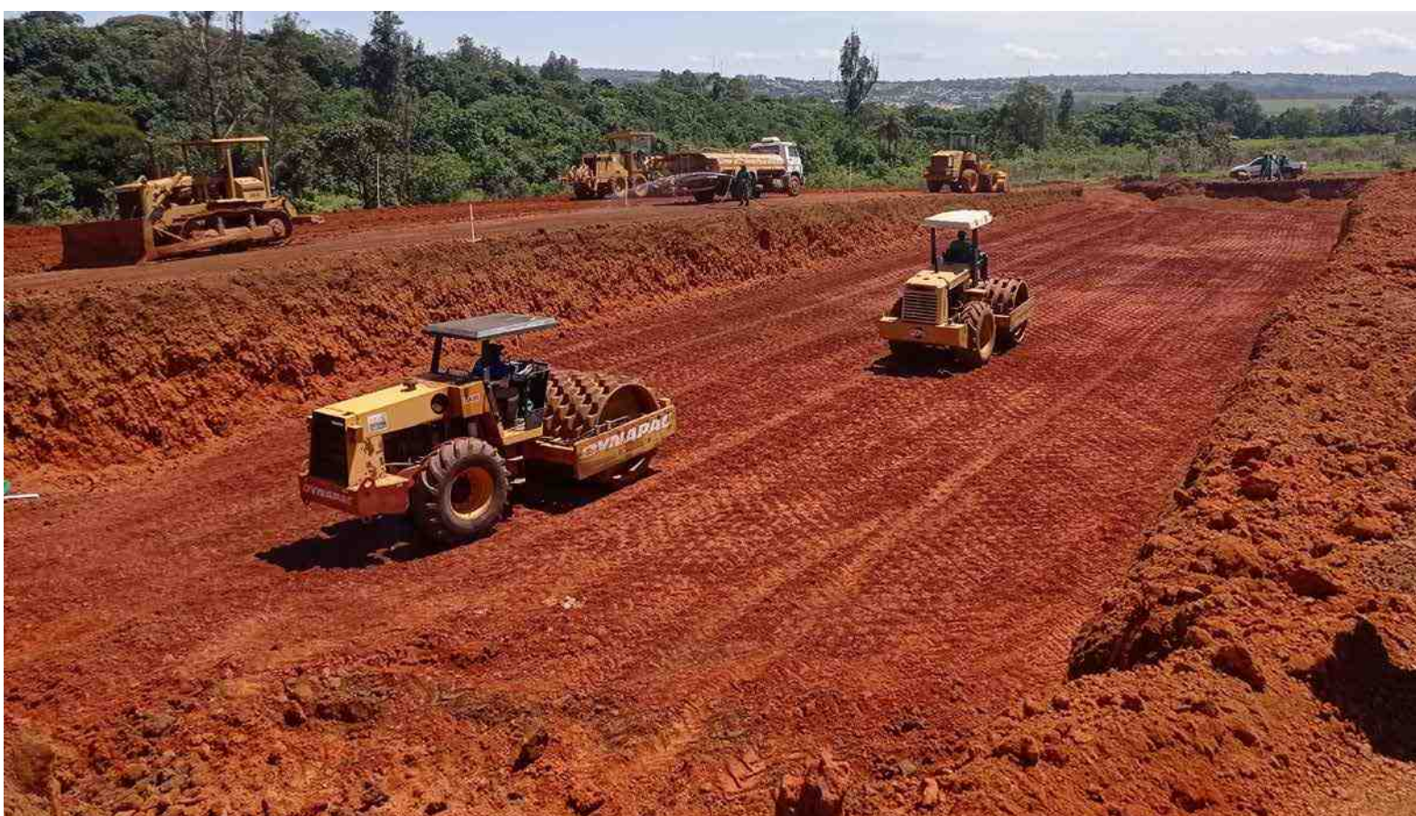
Início da construção da bacia de contenção da rede do Centauros
