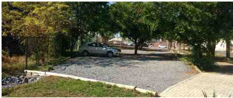
Construção do estacionamento da área da feirinha
