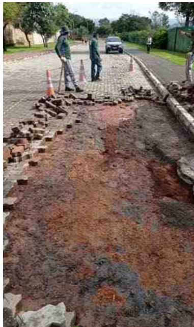
Recuperação de trechos danificados das ruas do RK em decorrência das águas de chuva que ainda correm superficialmente
