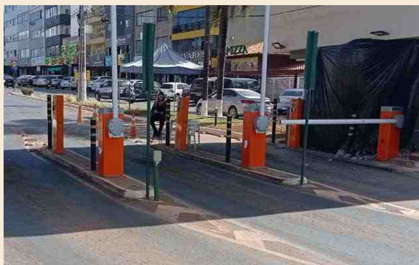
Reforma na guarita para instalação do novo sistema de acesso
